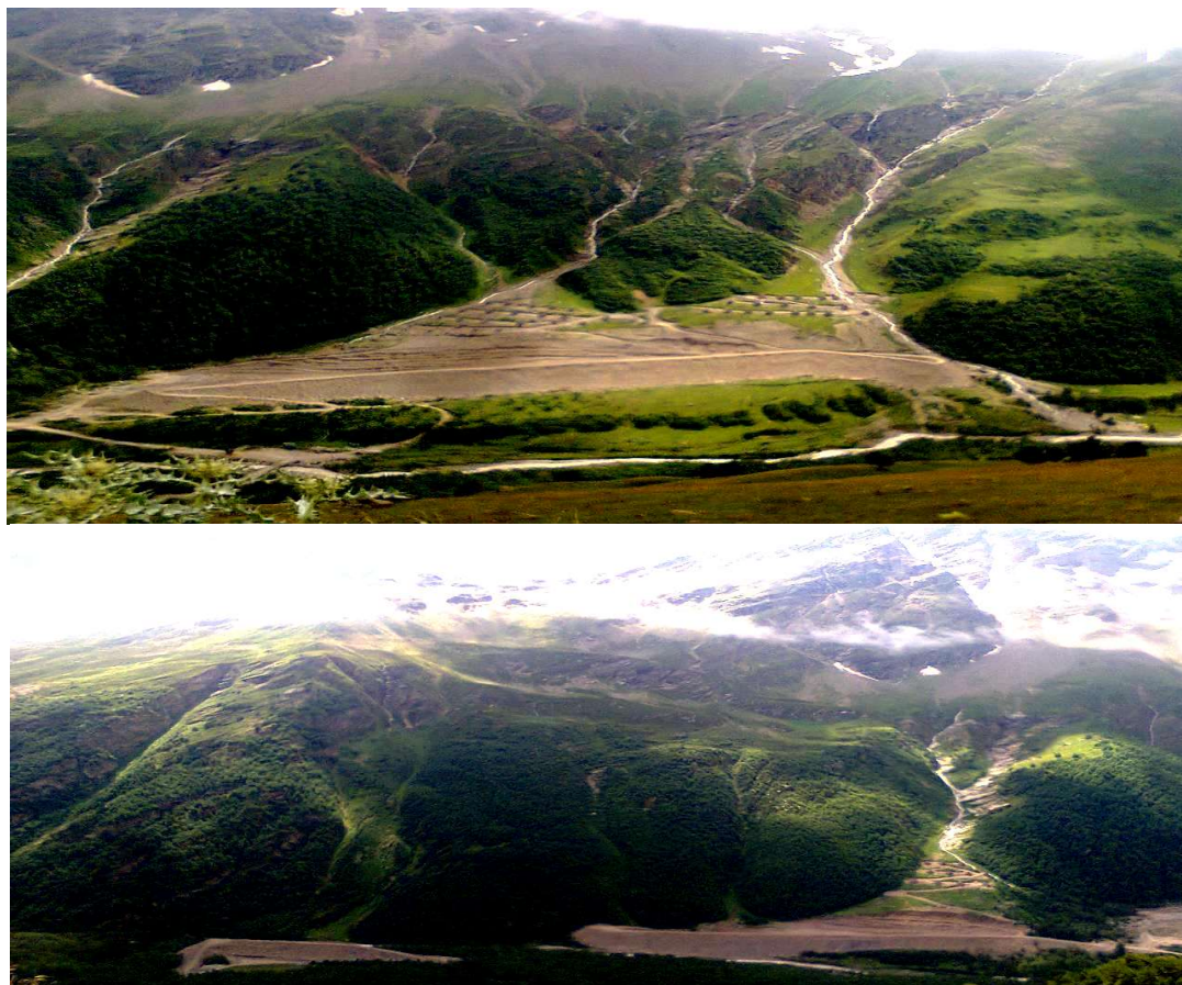
Рисунок 4.7 – Комплекс противолавинных сооружений (справа налево): отбойно-направляющая дамба (лавиносорбы №№ 61 (11) – 59 (12-13) и лавинотормозящие клинья (лавиносорб № 61 (11) (вверху); отбойно-направляющая дамба (лавиносорб №14 (58) (внизу) [162 – 163]
